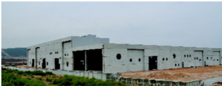
Yeni fabrikanın inşaatı hızla ilerliyor
